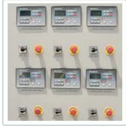
Çoklu Jeneratör ve Şebeke ile Paralel çalışma ve Güç Otomasyonu Panosu
