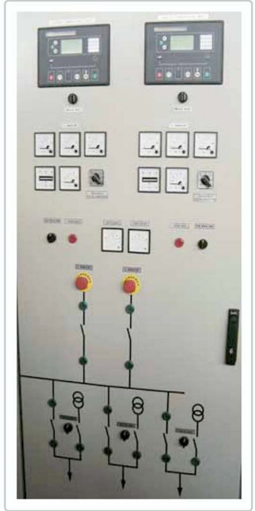
Çoklu Şebeke ve Çoklu Jeneratör Güç Otomasyonu ve Paralel Çalışma Panosu
